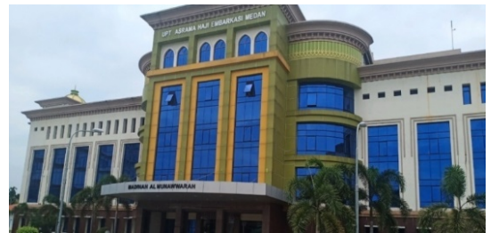
Gambar 11: fasad bagian timur bangunan (Sumber: Dokumentasi peneliti 2020)
