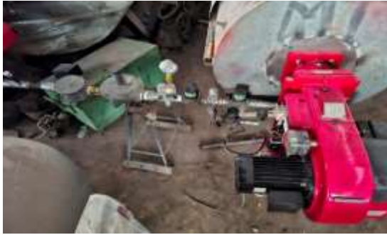
Gambar 4. Hasil perakitan piping dan perancangan instrumentasi.
