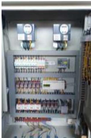
Gambar 7. Panel kontrol sistem pengaturan motor pompa
