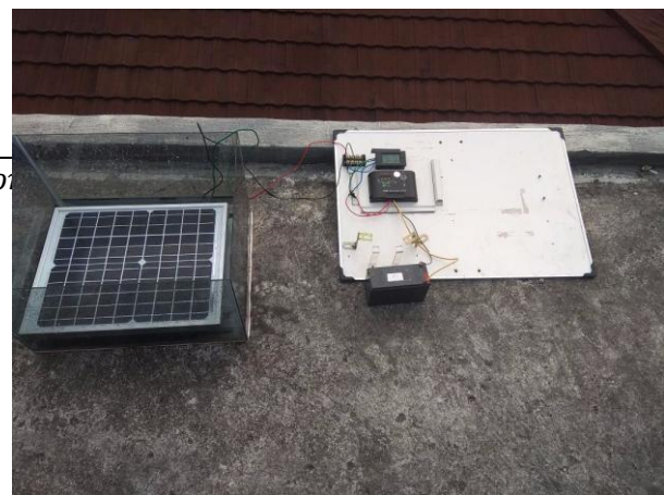
Gambar 11. Pengujian system pendingin panel surya menggunakan air mineral pada pencahayaan matahari langsung.
