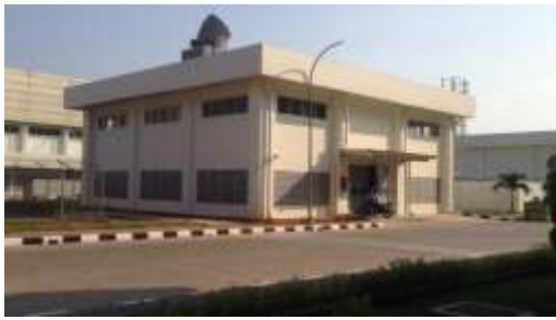
Gambar 2 Gedung utility / rumah pembangkit.
