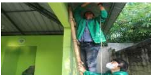
Gambar 7 Proses pencarian Sumber listrik AC 220V sebelum pemasangan kabel
