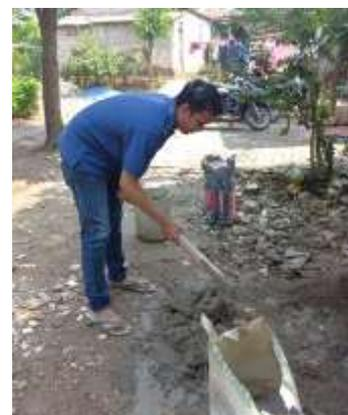
**Gambar 2** Proses pengadukan dengan bahan pasir dan semen untuk bak sampah
