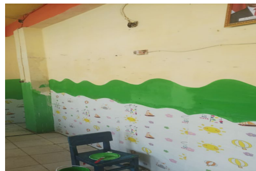
Gambar 10. Pengecatan ulang pada dinding dan penempelan wallpaper untuk perindah ruang kelas.
