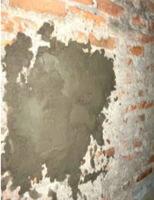
Gambar 3. Hasil Dari Uji coba Mesin Plester Tembok
