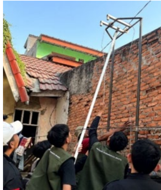
Gambar 1. Perakitan Mesin Plester Tembok
