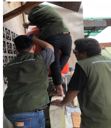
Gambar 1. Perbaikan Toren di TK Aisyiyah Busthanul Athfal PCA Senen.
