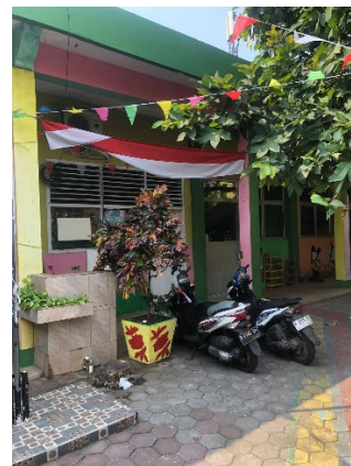
Gambar 3. Kondisi Existing TK Aisyiyah 73
