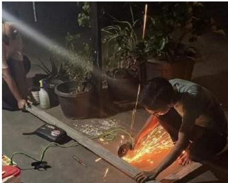
Gambar 5 : Menyiapkan Baja Ringan Sumber : Dokumentasi Pribadi, 2023
