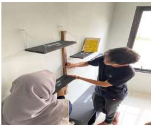
Gambar 2. Pemasangan ambalan buku dan rak buku
