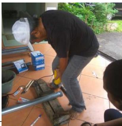
Gbr. 6 Pemasangan lampus LED bertenaga surya pada pemegang LED.
