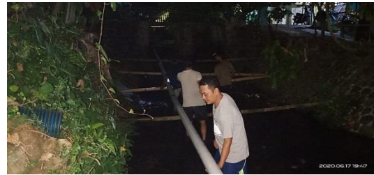
Gambar 3. Kegiatan Gotong Royong Pemasangan Pompa Hidram
