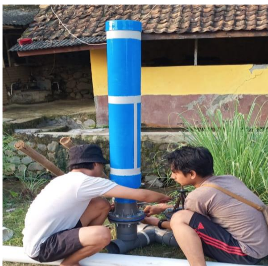
Gambar 2. Perakitan Pompa Hidram
