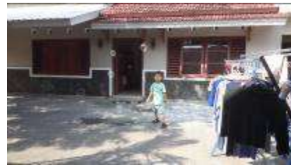
Gambar 5. Bangunan sisir/penunjang yang beralih fungsi menjadi rumah
