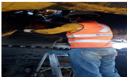
Gambar 13. Pemasangan lamp dan speaker
