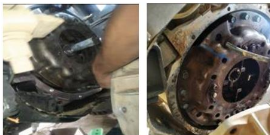
Gambar 18. Pemasangan Clutch Cover
