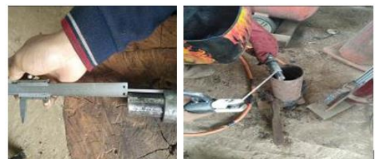
Gambar 14. Pemasangan dan Pengelasan Pin
