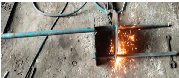
Gambar 20. Proses penggabungan besi hanger dan plat
