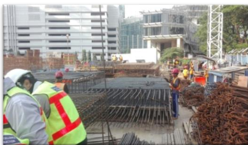
Fabrikasi sangkar tulangan shear wall manual
