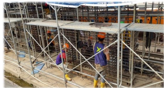
Fabrikasi sangkar tulangan shear wall rebar template
