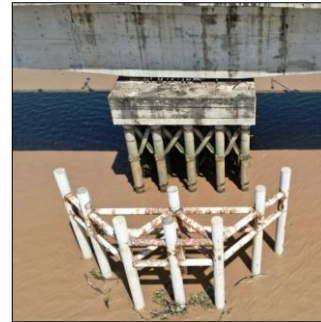
Gambar 1. Fondasi jembatan pedamaran II
