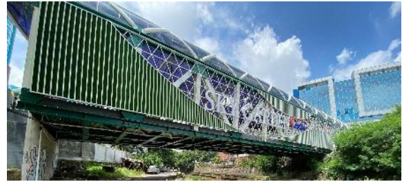
Gambar 1. Jembatan Sungai Ciliwung penghubung dua bangunan (rangka baja 55 m)
