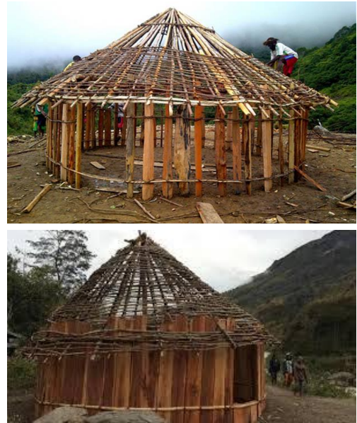
Gambar 2. Konstruksi rumah Honai Sumber : Arsitorstudio dan 99.co
