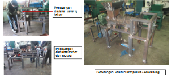
Gambar 6. Pembuatan Rumah Pengepress, Pemasangan unit Rangka dan Assembling
