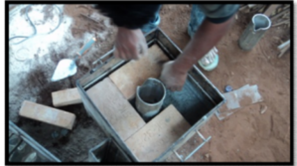
Gambar 6. proses pembuatan tungku peleburan logam
