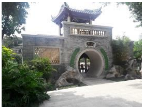
Gambar 2. Bangunan penunjang (Sumber: Dokumentasi pribadi, 2017)
