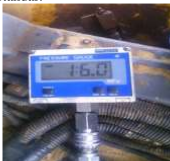
Gambar 3.65. Pressure fan pump
