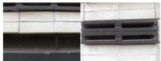
Gambar 5. Cross ventilation pada rongga-rongga dinding masjid
