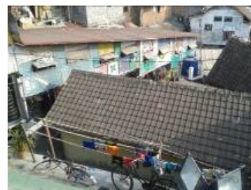
Gambar 5. Atap bangunan dengan material genteng dan asbes
