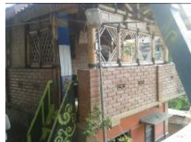
Gambar 4. Bangunan dengan konstruksi dinding kombinasi batu bata dan bambu
