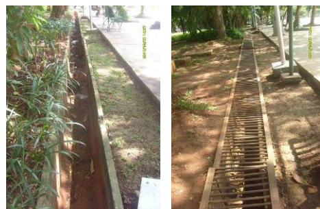
Gambar 11. Saluran drainase terbuka Saluran drainase tertutup Sumber : Dokumentasi Pribadi, 2013.
