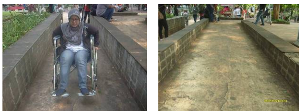
Gambar 2. Ramp untuk difabel Sumber : Dokumentasi Pribadi, 2013
