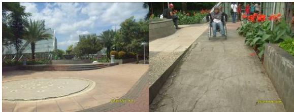
Gambar 5. Pintu / Area masuk dan ramp di Jalan H.O.S Cokroaminoto sekaligus sebagai sirkulasi pejalan kaki
