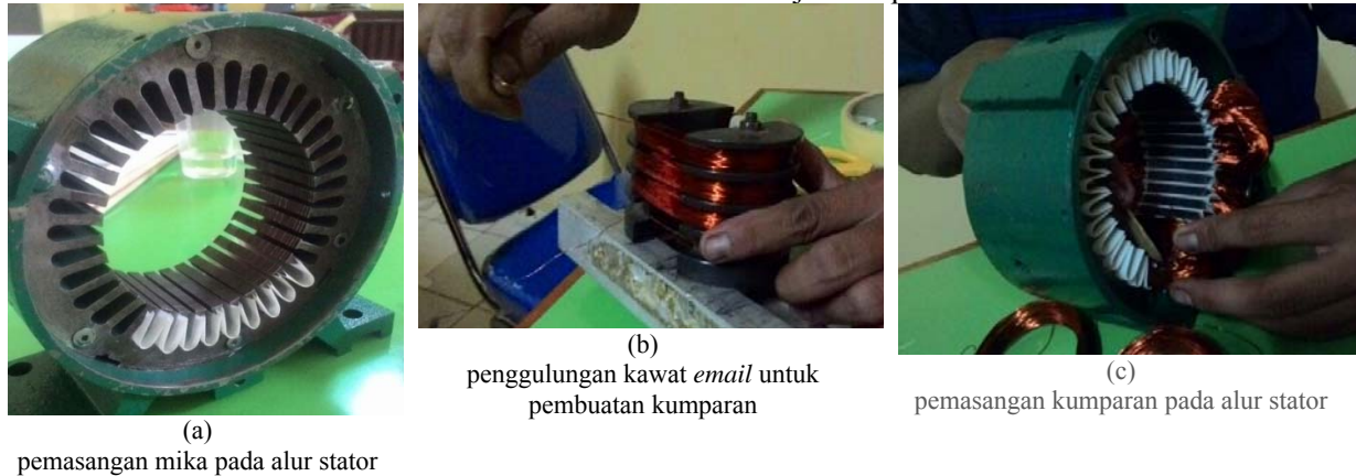
Gambar 2 Tahapan-tahapan pemasangan mika pada alur stator, isolasi mika pada alur stator, penggulangan kawat email untuk pembuatan kumparan, dan pemasangan kumparan
