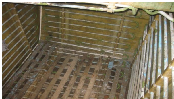
Gambar 7. Bentuk pipa evaporator di dalam palka
