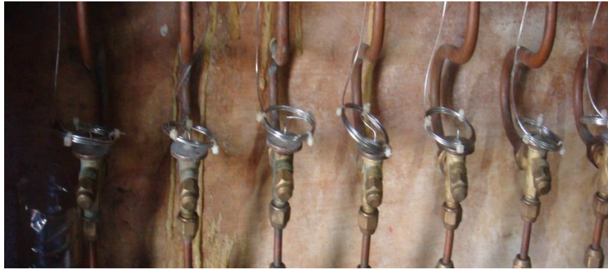
Gambar 8. Katup Ekspansi Jenis Pipa Kapiler
