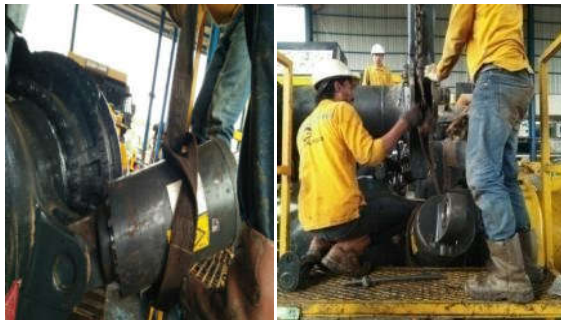
Gambar 4. Proses Install Rear Suspension Menggunakan Belt
